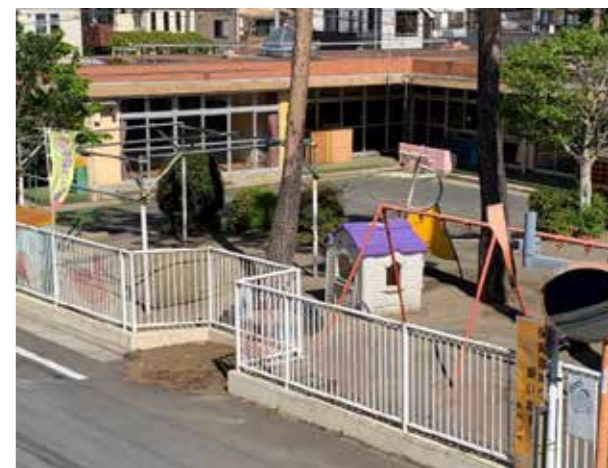
解体工事が始まった旧萩山第二保育園舎
